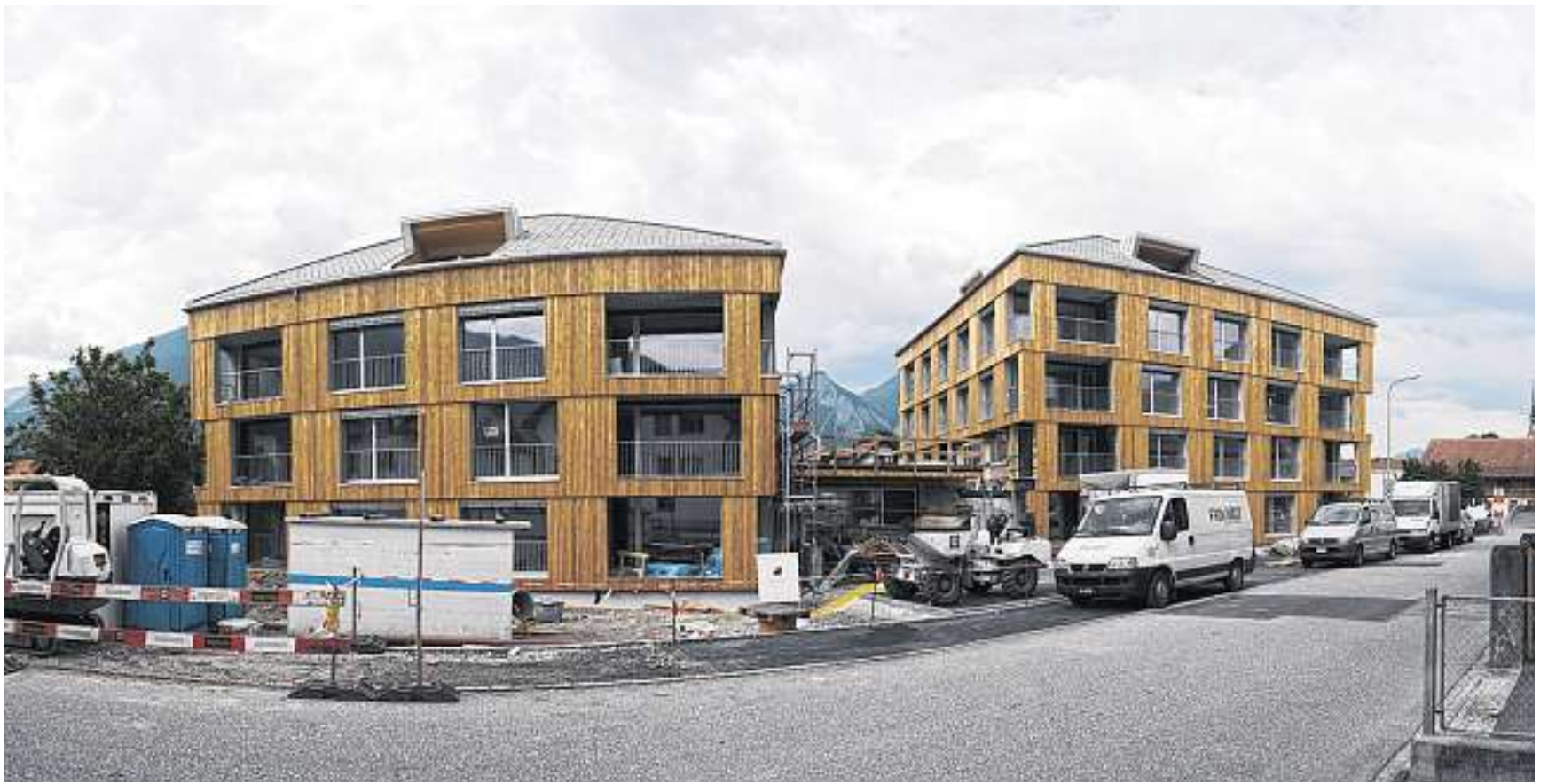
Vor der Fertigstellung: In Bonaduz entsteht das erste genossenschaftliche Projekt im Kanton Graubünden für das Wohnen im Alter von 55+.
